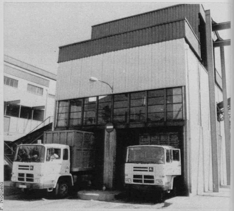
Este es un clasificador de desechos. Tras la trituración, los materiales inutilizables son cargados en camiones con destino a los vertederos.
