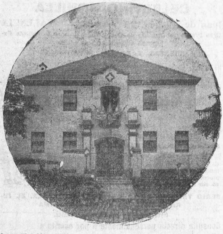
Frete del Hospital de Nueva Pompeya, populoso barrio obrero que, por la iniciativa de los concejales socialistas de Buenos Aires, cuenta desde el mes de diciembre de 1926 con su hospital vecinal.
